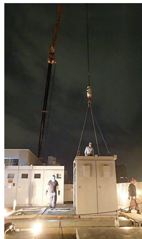
受変電設備更新工事
