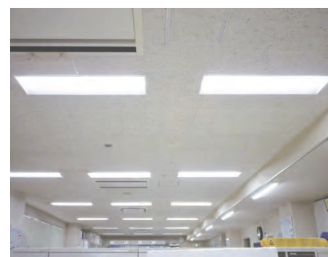
照明LED化工事
