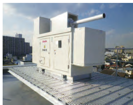
発電機更新工事
