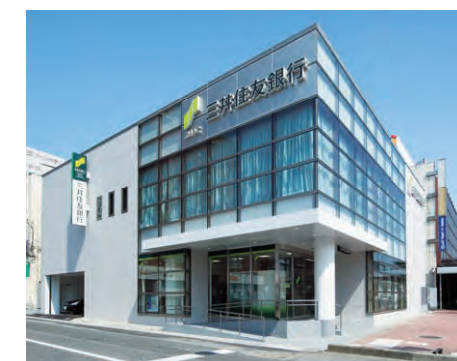
銀行支店 内装・設備工事
