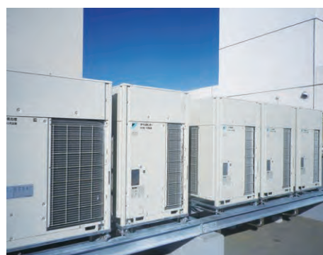
空調設備更新工事
