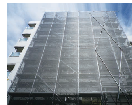
社宅 外装工事
