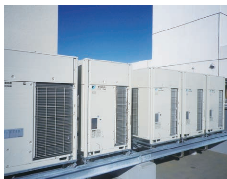
空気調和設備更新工事
