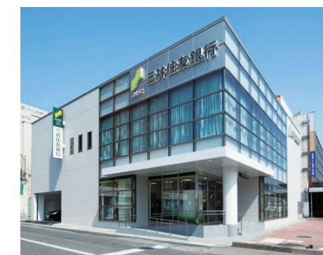
銀行支店 内装・設備工事
