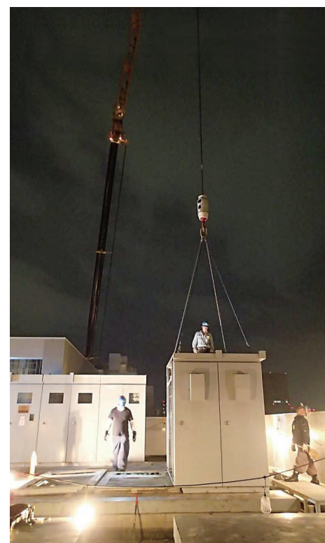
受変電設備更新工事
