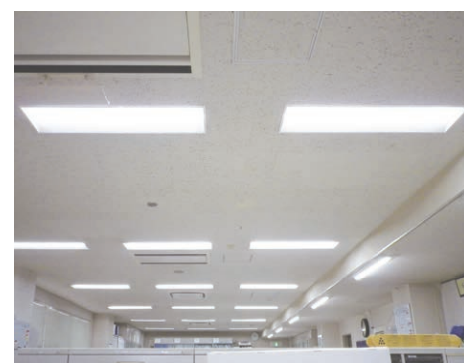
照明LED化工事
